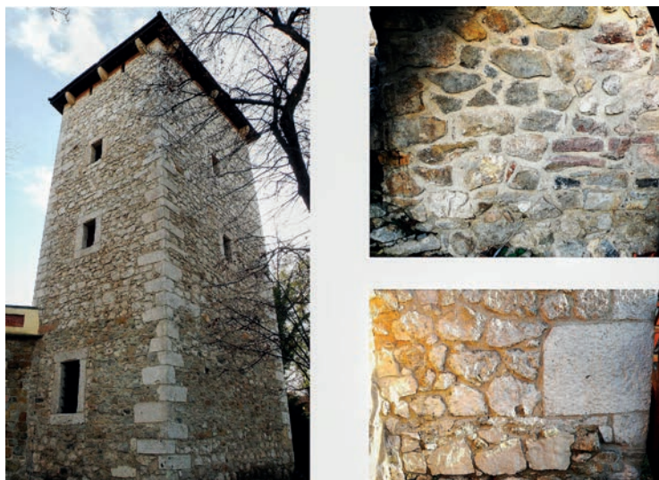
Fot. 11. Baszta obronna. Po prawej dwa lica murów baszty: u góry łamane bloki jurajskiego wapienia skalistego z ciosanym blokiem wapienia gruboławicowego (węgiew) oraz z uzupełnieniami piaskowcem szydlowieckim; poniżej konstrukcja z łamanego piaskowca lokalnego (Biskupice i okolice)
