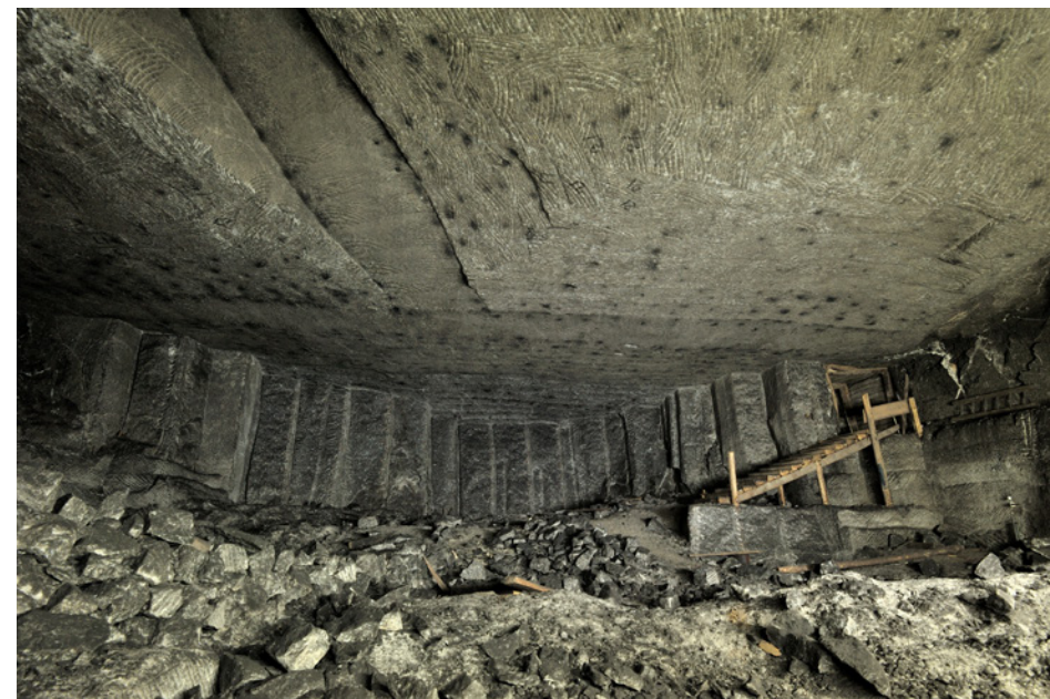
12. Komora Parnas. Negatywy oderwanych kłapci. Stropy chodników rozcinających bryłę soli zielonej typowej (fot. K. Kozłowski)
