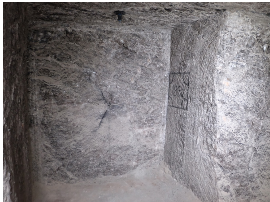
9. Komora Magdalena. Czoło chodnika rozpoznawczego w pokładzie soli szymbikowej i data określająca czas jego powstania (fot. R. Zadak)
