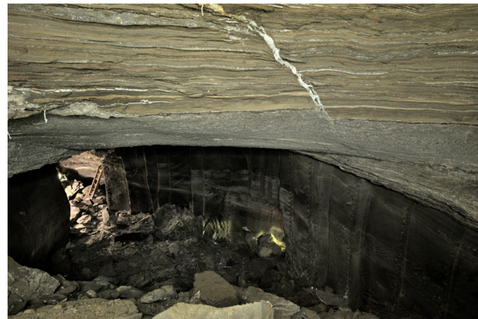
16. Komora Ksawer Dolny . Uszkodzenie solnej łuski ochronnej powodujące postępujący obwał skał płonnych ze stropu (fot. K. Kozłowski)
