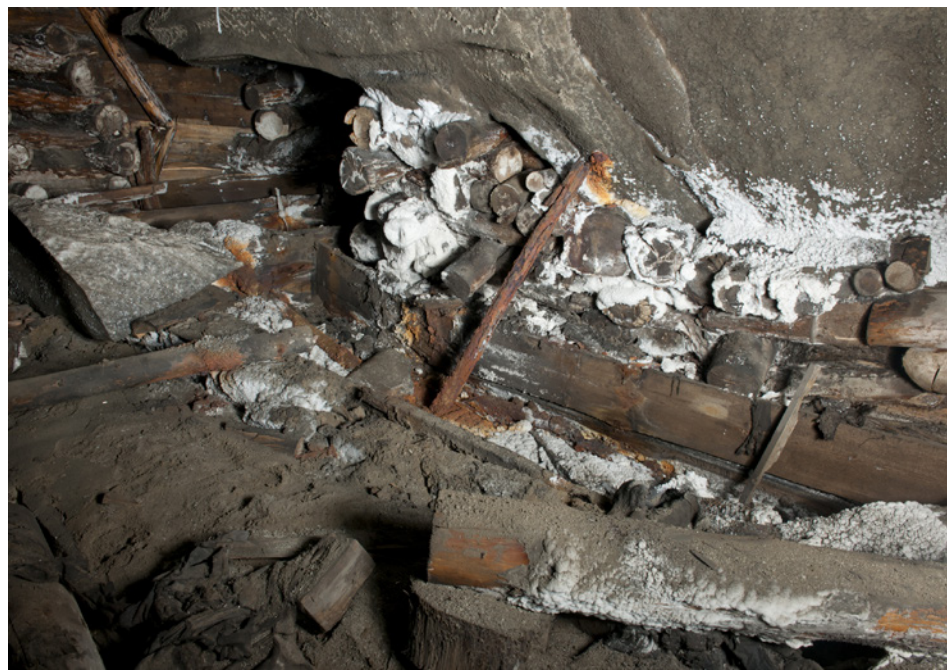
24. Drewniane koryta do odprowadzania wody z wycieku – komora Kloski na V poziomie wielickiej kopalni soli, 2017 r. (fot. A. Grzybowski, MŻKW)
