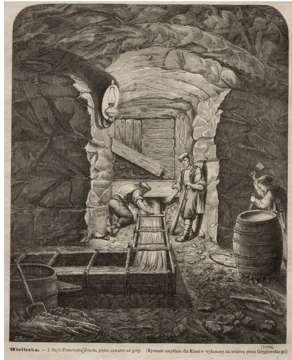
9. Górnicy nadzorujący wypływ wody zza tamy w poprzeczni Kloski na poziomie V, w okolicy szybu Regis.
