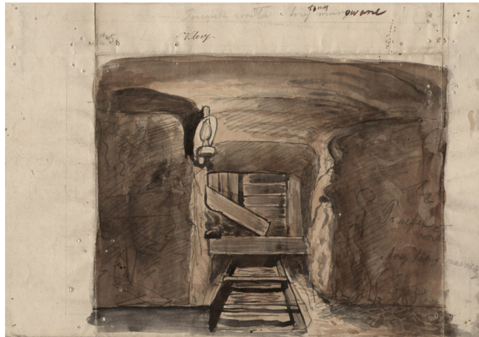
8. Szkic tamy w poprzeczni Kłoski na poziomie V, w okolicy szybu Regis. Początek źródła i trzy tamy murowane, A. Gryglewski, 1868
