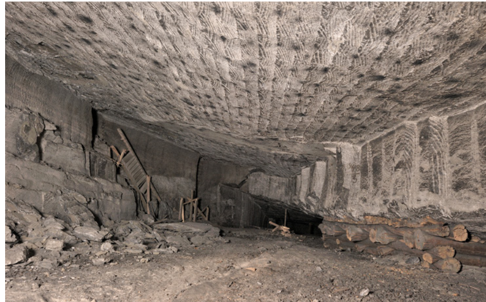
13. Komora Leopold Górny. Faktura stropu i ociosów po eksploatacji ręcznej (fot. K. Kozłowski)
